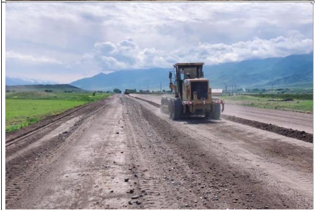
Рисунок 4 Работы на участке
