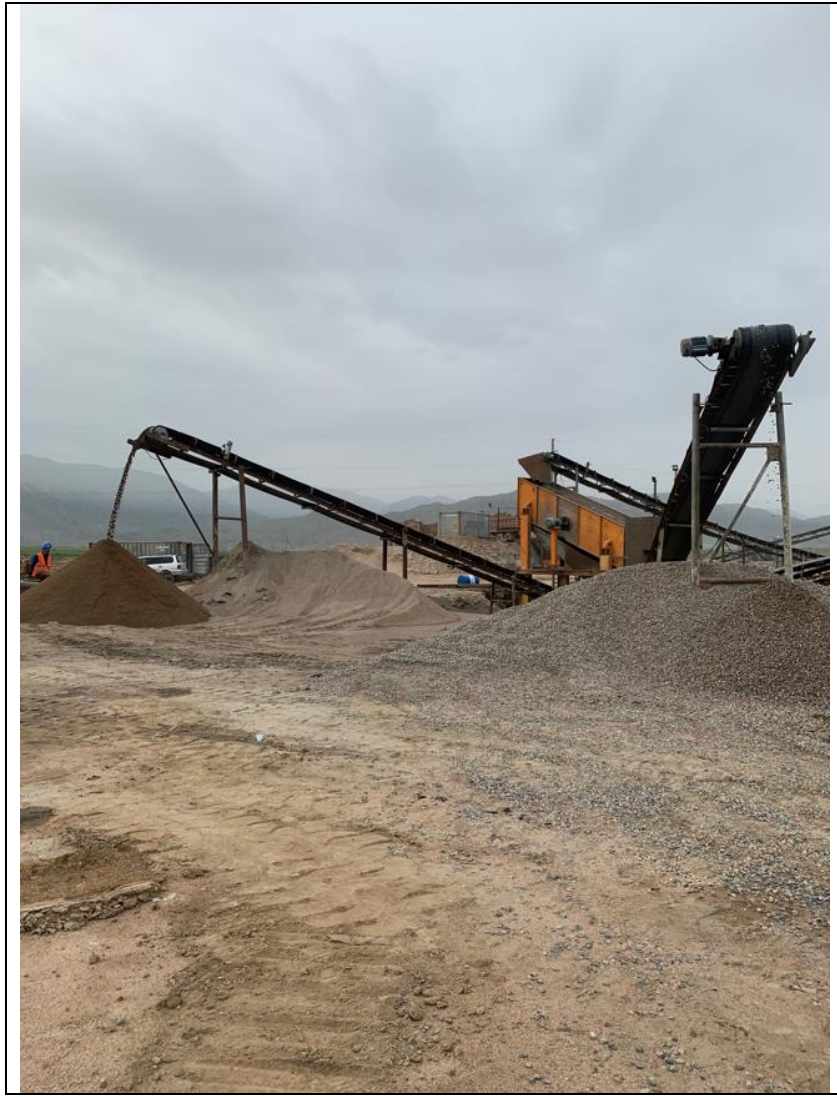
Рисунок 12 ДСУ на территории производственной площадки
