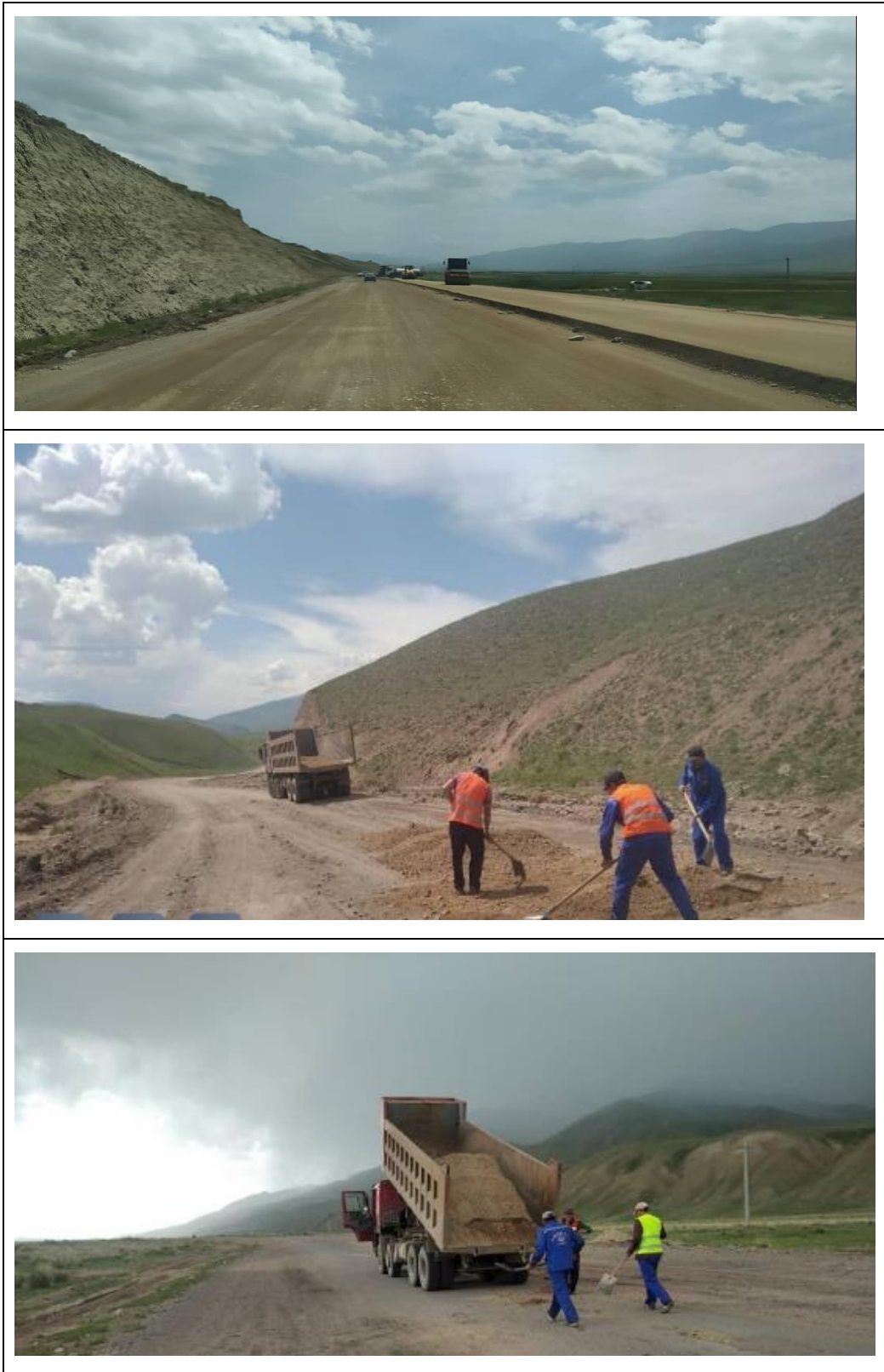
Рисунок 15 Работы на дороге
