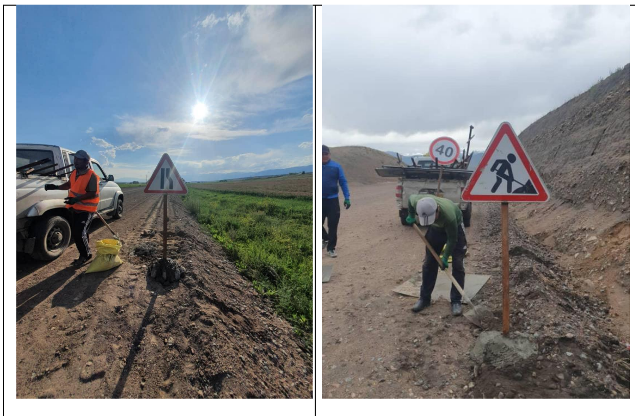
Рисунок 3 Установка временных дорожных знаков на дороге
