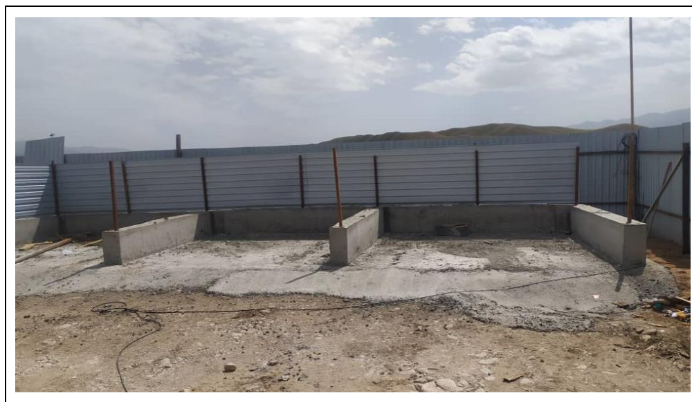
Рисунок 20. Подготовка площадки для отходов на территории лагеря
